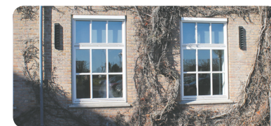
Skærmtype D: Lodret skærm, som monteres ved siden af vinduerne ved pladsmangel eller ved montage af de store MicroVent-modeller. Her på Tietgenskolen i Odense.
