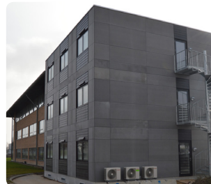
Per Aarsleff A/S, Hvidovre Flytbar kontorbygning
