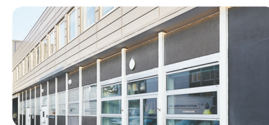
Skærmtype E: MicroVent kan monteres i vinduernes glasfelt, hvilket giver nem installation og gør ventilationen yderst diskret. Som her på Glostrup Hospital.
