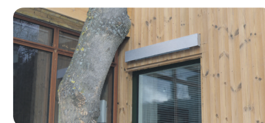
Skærmtype C: En skærm, som kan tilpasses bredden af vinduet, og hvor ventilationen er centreret over vinduet. Som her hos Børnehaven Marthagården på Frederiksberg.
