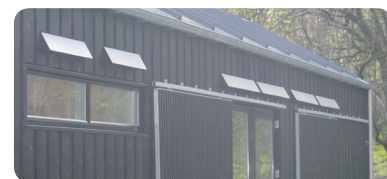
Skærmtype A: MicroVents standardskærm med 60 graders hældning. Især ideel til modulbyggeri og lette konstruktioner som Børnehaven Himmelblå i Randers.
