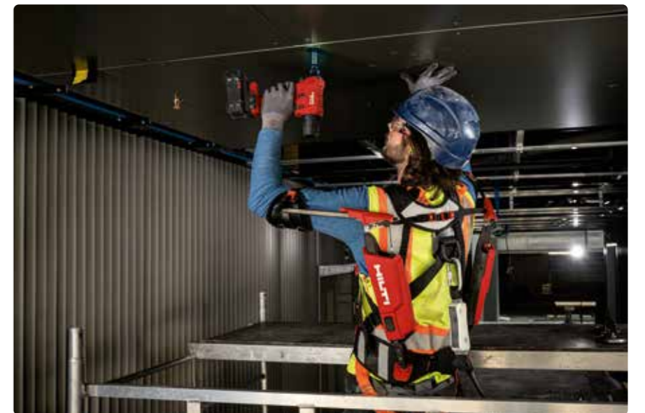
Exoskeletter har været benyttet af medarbejderne i Jysk Elteknik i godt halvandet år. Foto: Modelfoto - TEKNIQ Arbejdsgiverne
