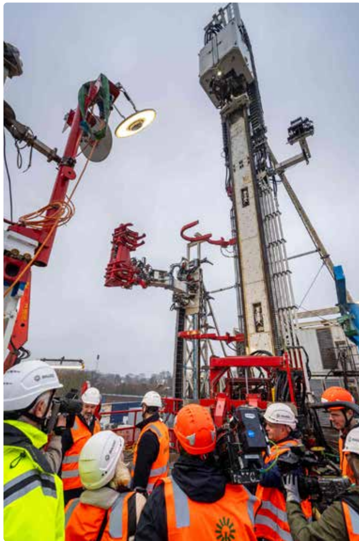
Innargi startede boringen efter det varme vand 2.500 meter under jorden ved Aarhus havn i november 2023. Efter planen skal anlægget stå klar 2027. Foto: Per Bille/Innargi
